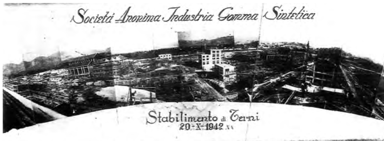
Anno 1942 - Lo Stabilimento della S.A.I.G.S. in costruzione
