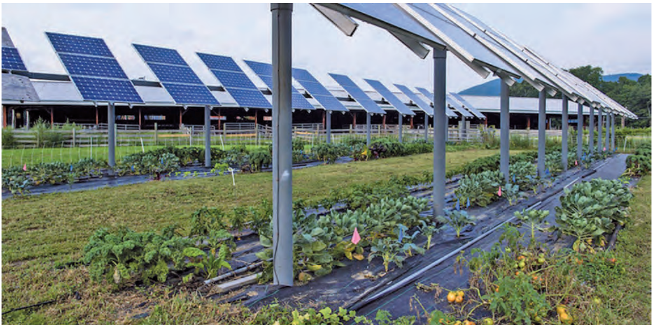
Fig. 4. Posizionando su un campo coltivabile i pannelli fotovoltaici con appropriata inclinazione e distanza e a un'altezza di un paio di metri dal suolo si ottengono con buona efficienza cibo ed energia.
