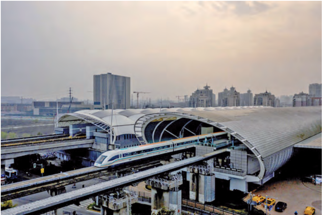
Fig. 3. Il tetto della stazione di Shanghai è coperto da pannelli fotovoltaici che forniscono elettricità ai treni.
