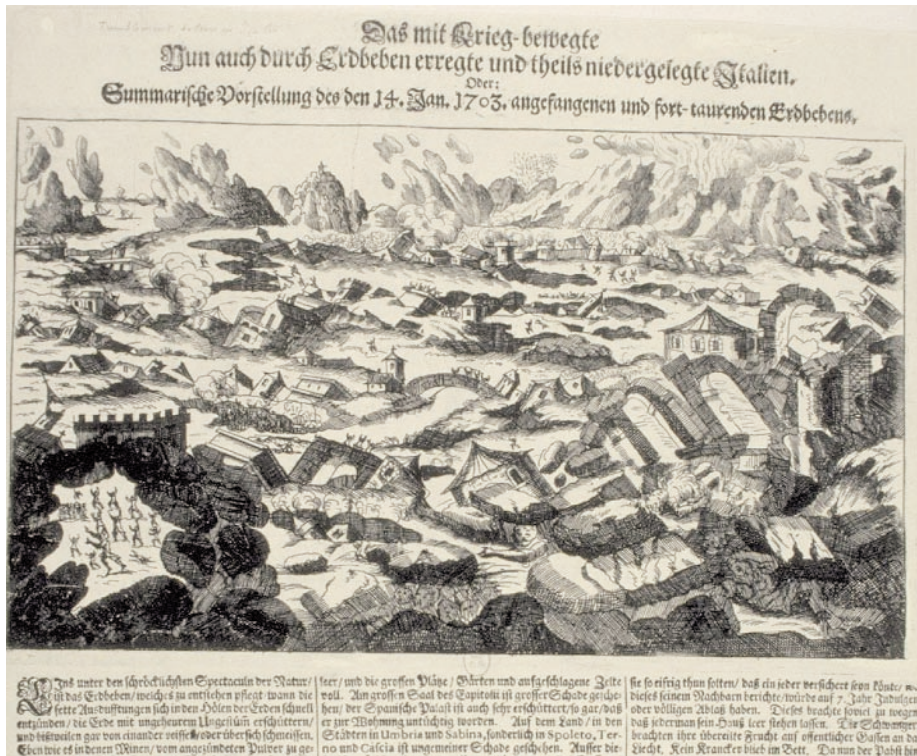
Fig. 8. Una rara stampa sugli effetti del terremoto del 1703, in una relazione di area tedesca. La scena, forse immaginata dal disegnatore sulla scorta delle descrizioni, si poneva l'obiettivo di comunicare il dramma di rovine estesissime e irrimediabili, avvenute in un territorio ignoto alla maggior parte dei lettori.
