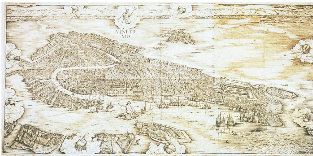
Fig. 15. Intero dopo il restauro.
