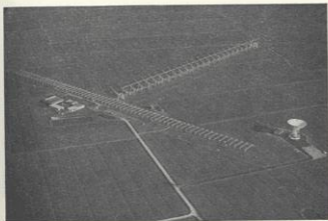
Fig. 2. La Stazione Radioastronomica di Medicina (Bologna) dell'Istituto di Radioastronomia C.N.R. con il radiotelescopio «Croce del Nord». Il braccio Est-Ovest è costituito da un riflettore cilindrico-parabolico posizionabile in declinazione lungo 600 m e con apertura di 35 m, mentre il braccio Nord-Sud è formato da 64 antenne cilindro-paraboliche disposte su una lunghezza complessiva di 640 m. In basso a destra nella figura il nuovo radiotelescopio del progetto VLBI.
