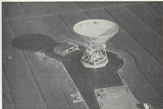
Fig. 8. Il radiotelescopio con riflettore parabolico di 32 m d'apertura della stazione VLBI di Medicina dell'Istituto di Radioastronomia del C.N.R.
