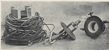
Fig. 1 - Lampada elettrica subacquea smontata, costruita per l'Istituto Zoologico di Catania. Modello originario del 1914.
